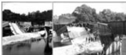
La passerelle Denfert-Rochereau détruite par les allemands
